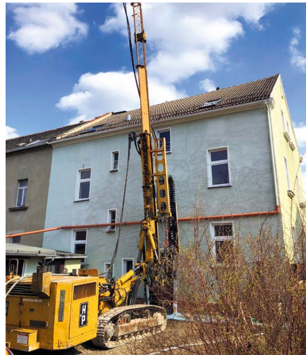
Bohrfahrzeug zur Erstellung der HDI-Bohrungen
