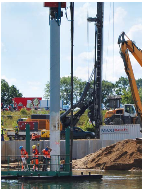
Setzen einer 5 Tonnen schweren Anlege-Dalbe am Wasserwanderrastplatz Geierswalde
