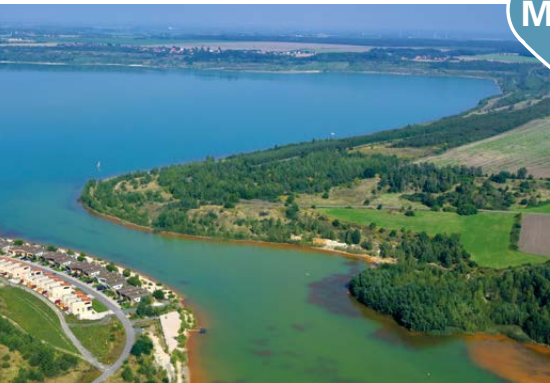
Fläche des geplanten Campingplatzes
