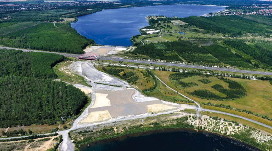
Trasse des entstehenden Harthkanals zwischen Cospudener See und Zwenkauer See, 2020
