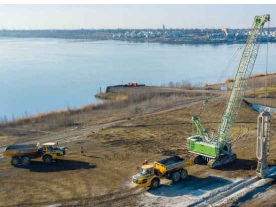
Bau der Dichtwand am Harthkanal
