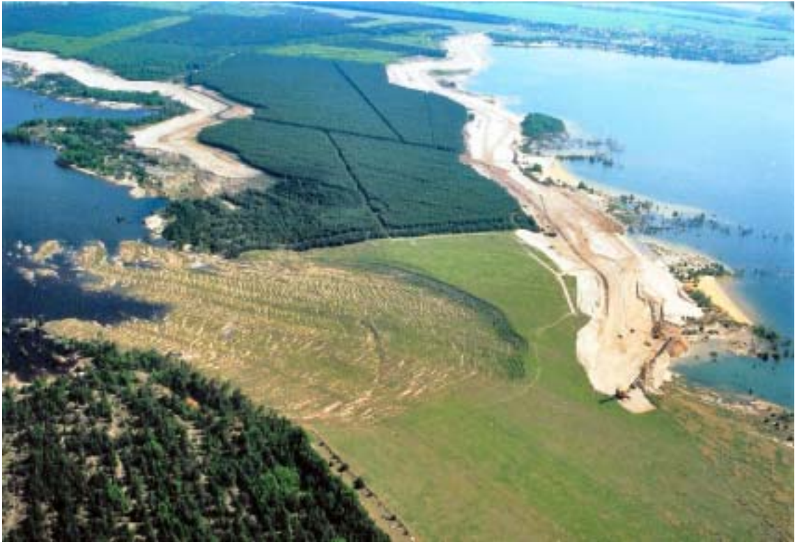
Setzungsfließbrutchung und Trassen zur Herstellung versteckter Dämme (Foto: BUL Sachsen GmbH)
