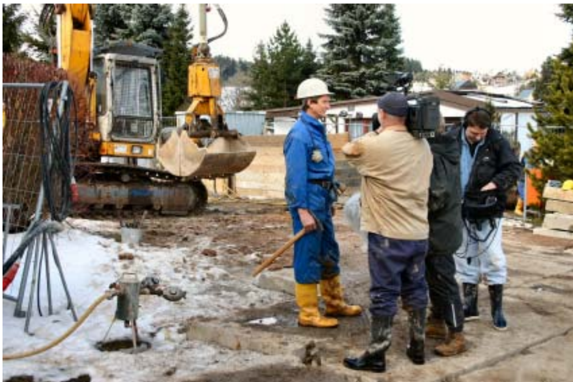
Sanierung des tiefen Hauptstollens in Geyer – Ein Team des MDR- Sachsenspiegel berichtet (Foto: Sächsisches Oberbergamt)
