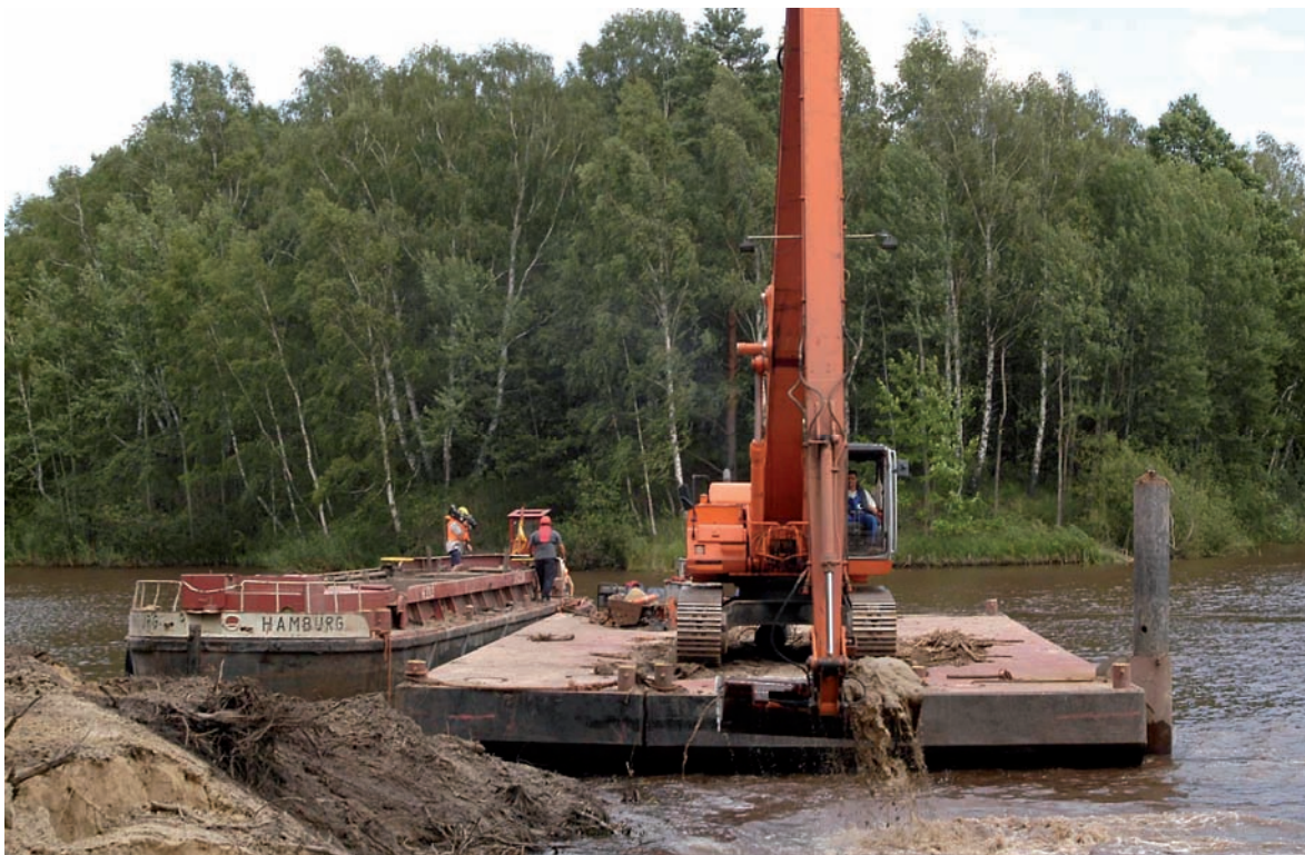
Schutzgrabenbaggerung im Knappensee, ehemaliger Tagebau Werminghoff I (Foto: LMBV mbH)
