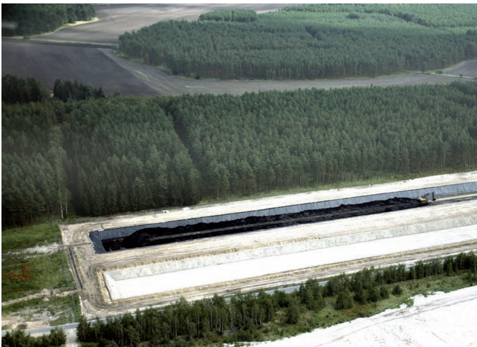
Bau von Vorratsbecken zur Einlagerung von Badetorf am Tagebau Nochten
