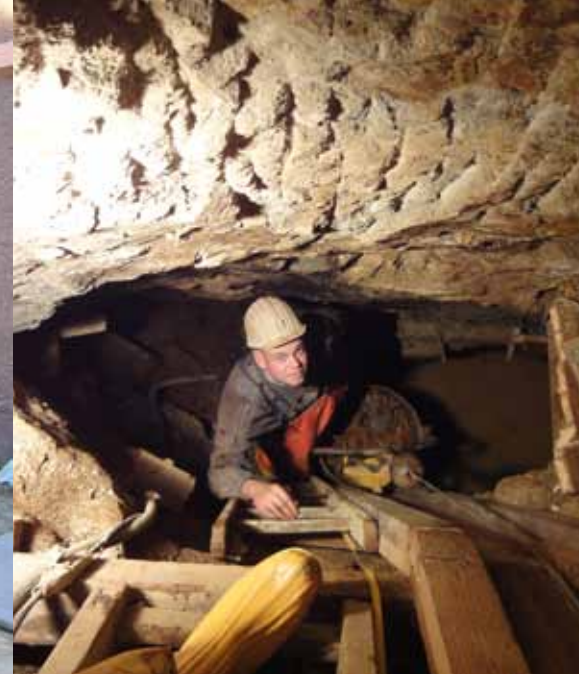
Foto links: Verhärungsarbeiten unter der Herrengasse in Dippoldiswalde (Foto: Bergsicherung Freital GmbH)
