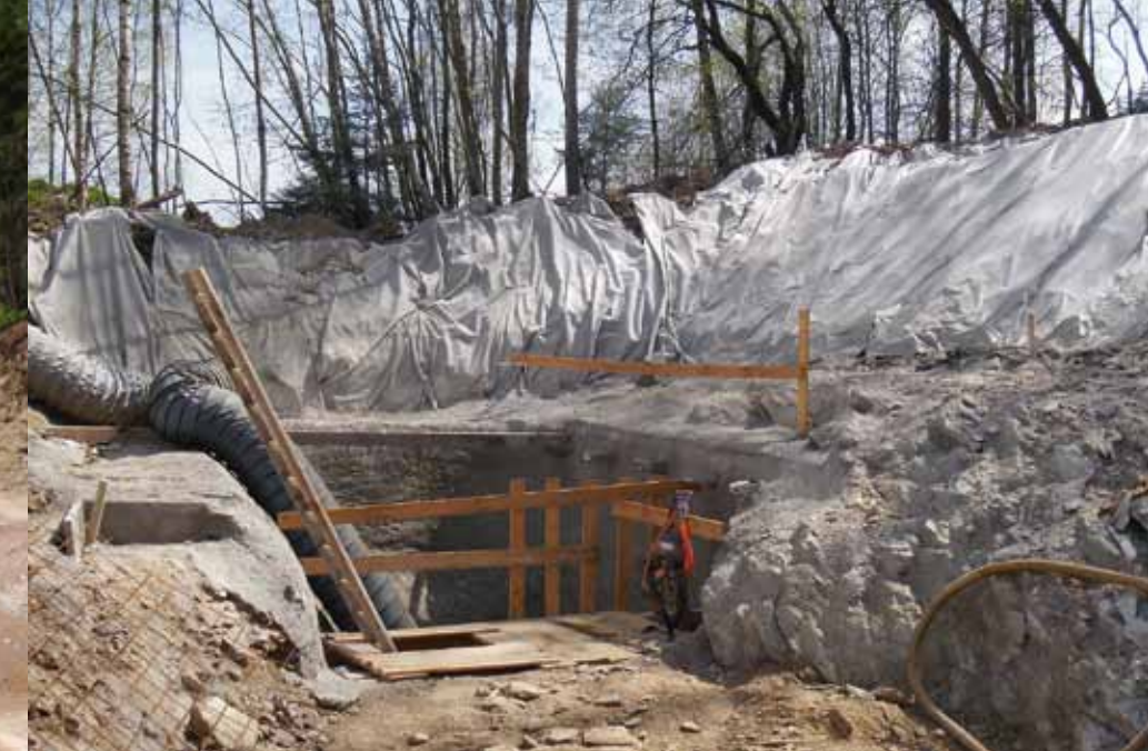
Foto 1: Auffahrung des Wismut-Stolln unter Freital (Foto: Wismut GmbH)
