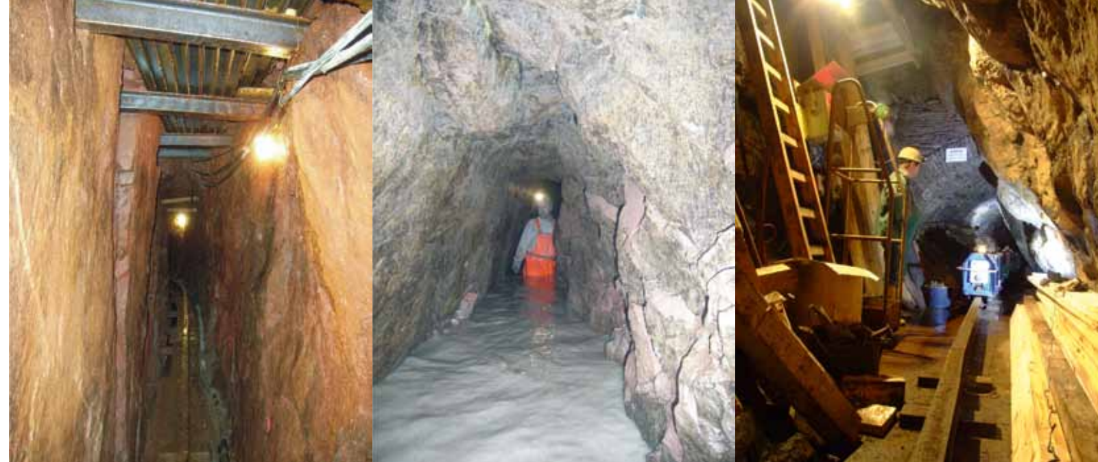
Foto 1 und 2: Befahrung und Firstausbau im Tiefer Hilfe Gottes Stolln Zinnwald (Fotos: Sächsisches Oberbergamt)
