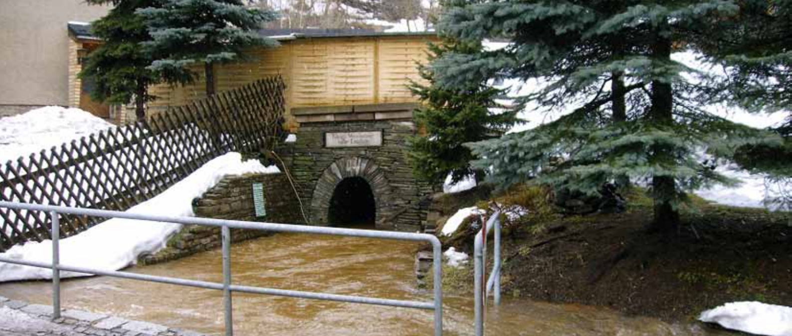
Foto: Mundloch des Königlich Weißtaubner Tiefen Erbstollns zur Entwässerung des Marienberger Grubenreviers bei Tauwetter am 19. März 2005 (Foto: Sächsisches Oberbergamt)
