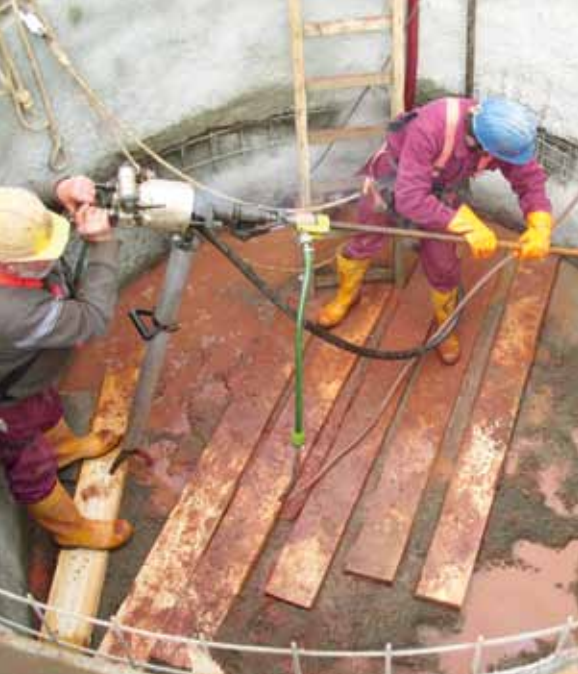
Foto links: Verhärarbeiten über dem Urbanus Stolln (Foto: BTOe Bergbau und Tiefbau GmbH Oelsnitz)
