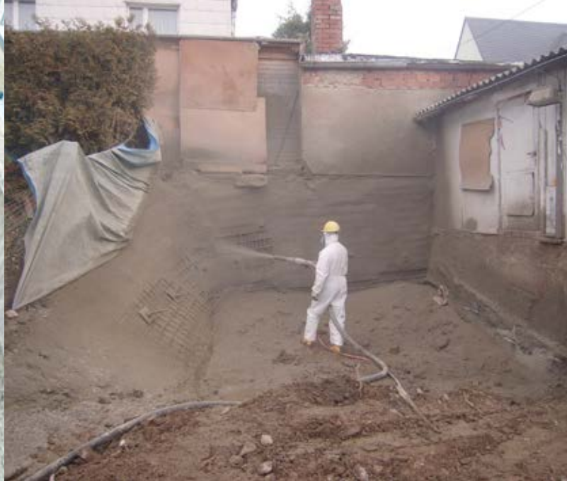
Foto links: Baustelle Gefahrenabwehr Karlsbader Straße in Annaberg-Buchholz – Sicherung der Einbruchsstelle (© Schachtbau Nordhausen GmbH)
