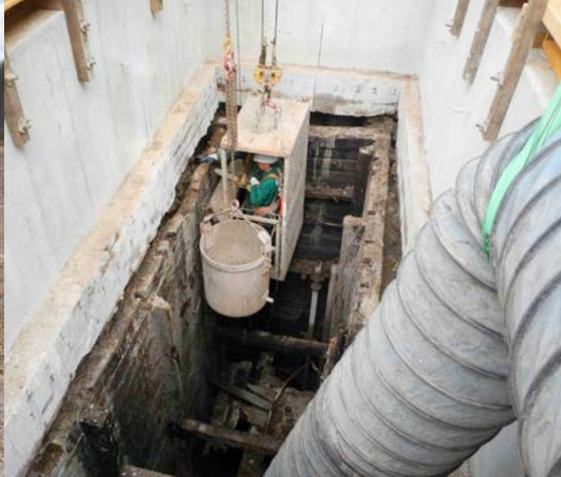
Foto links: Sanierung Wismut-Altstandort Halde – Haldenaufbereitung (© Wismut GmbH)
