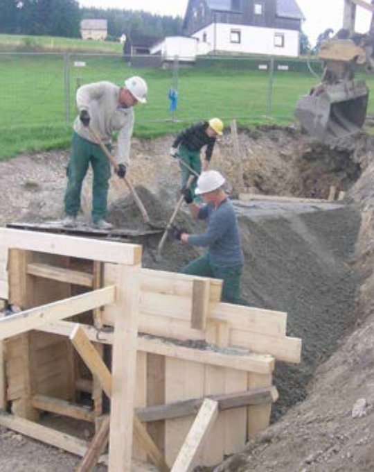
Foto: Errichtung Stollenmundloch als Zugang zum Sankt-Johannes-Erbstolln (© TS Bau GmbH)
