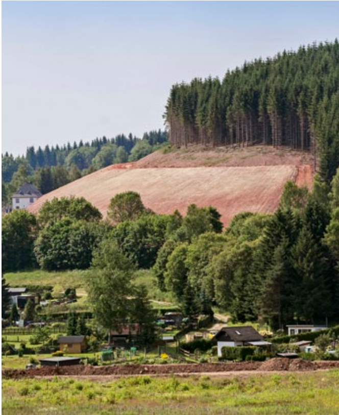
Sanierung der Halde 54 in Johanngeorgenstadt
