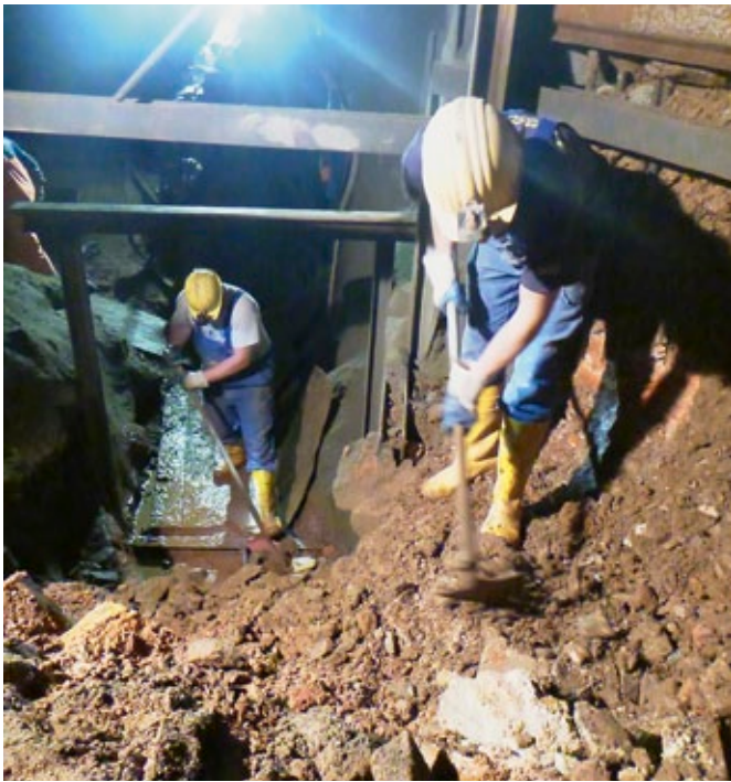
Aufwältigung Entwässerungssystem unter der Geyerschen Binge – Beräumung von Verbruchmassen am Schwarzen Bruch
