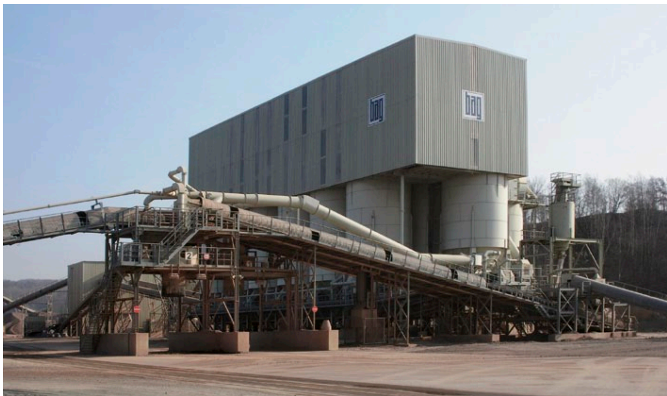
Verladeanlage im Quarzporphyrtagebau Großsteinberg
