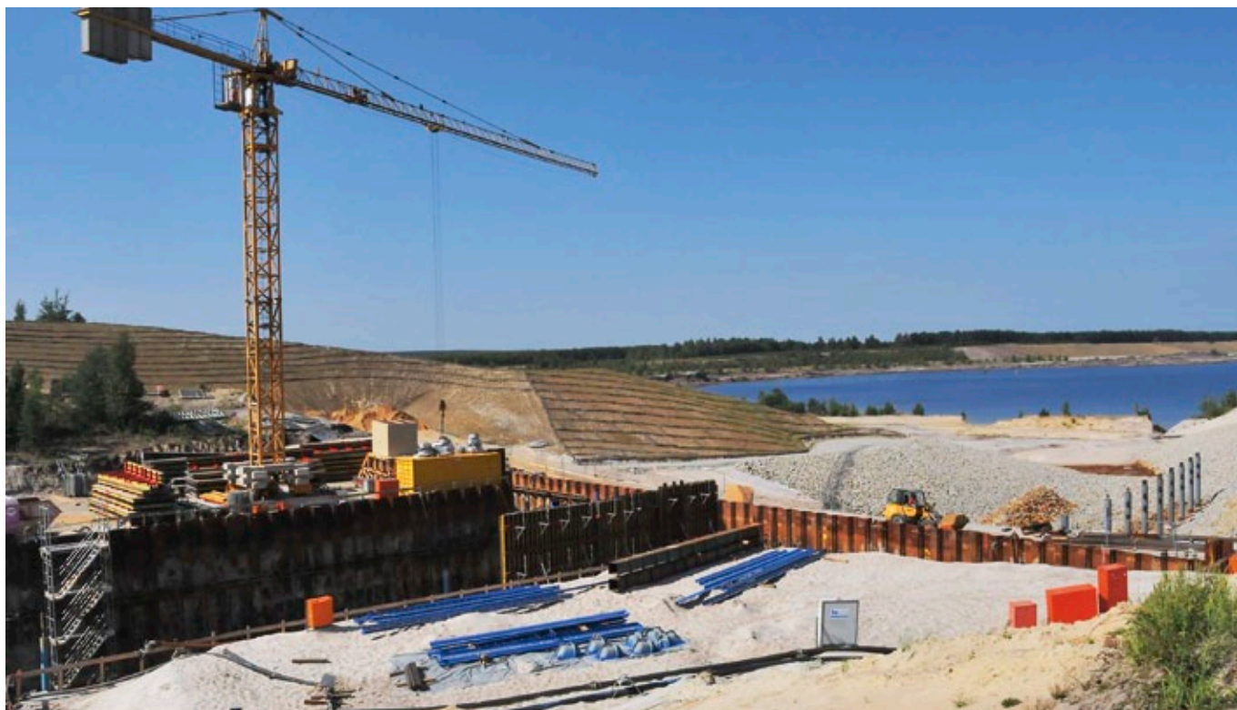
Bau der Schleuse an der schiffbaren Verbindung Spreetal-Sabrodt See – Überleiter 1
