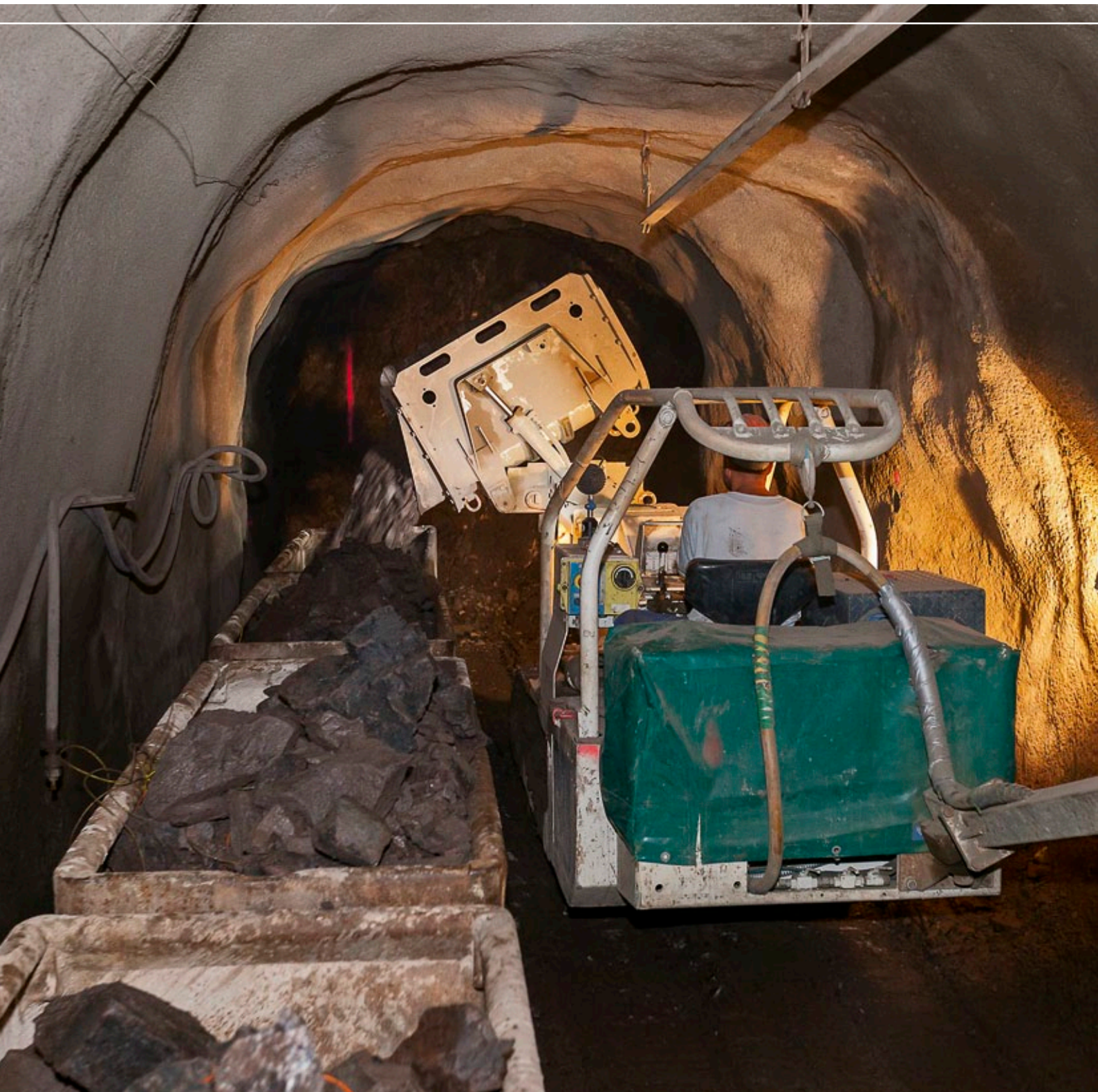
Auffahrung des Wismut-Stolln in Freital – Befüllen der Hunte mit Haufwerk im Ostteil des künftigen Wasserlösestollens
