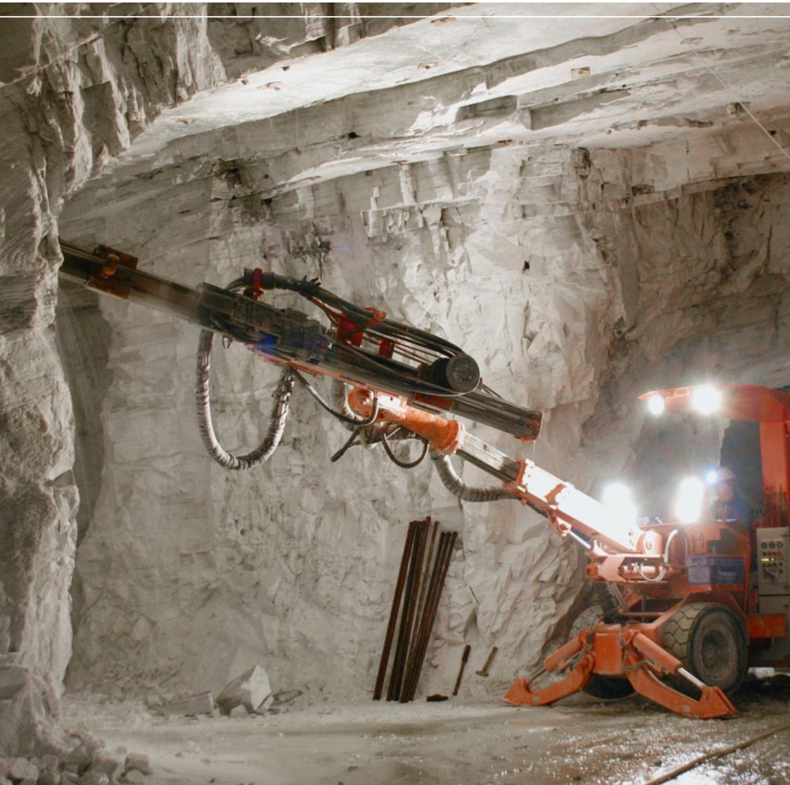
Ankerarbeiten mit Bohrwagen im Marmor-Bergwerk Hammerunterwiesenthal
