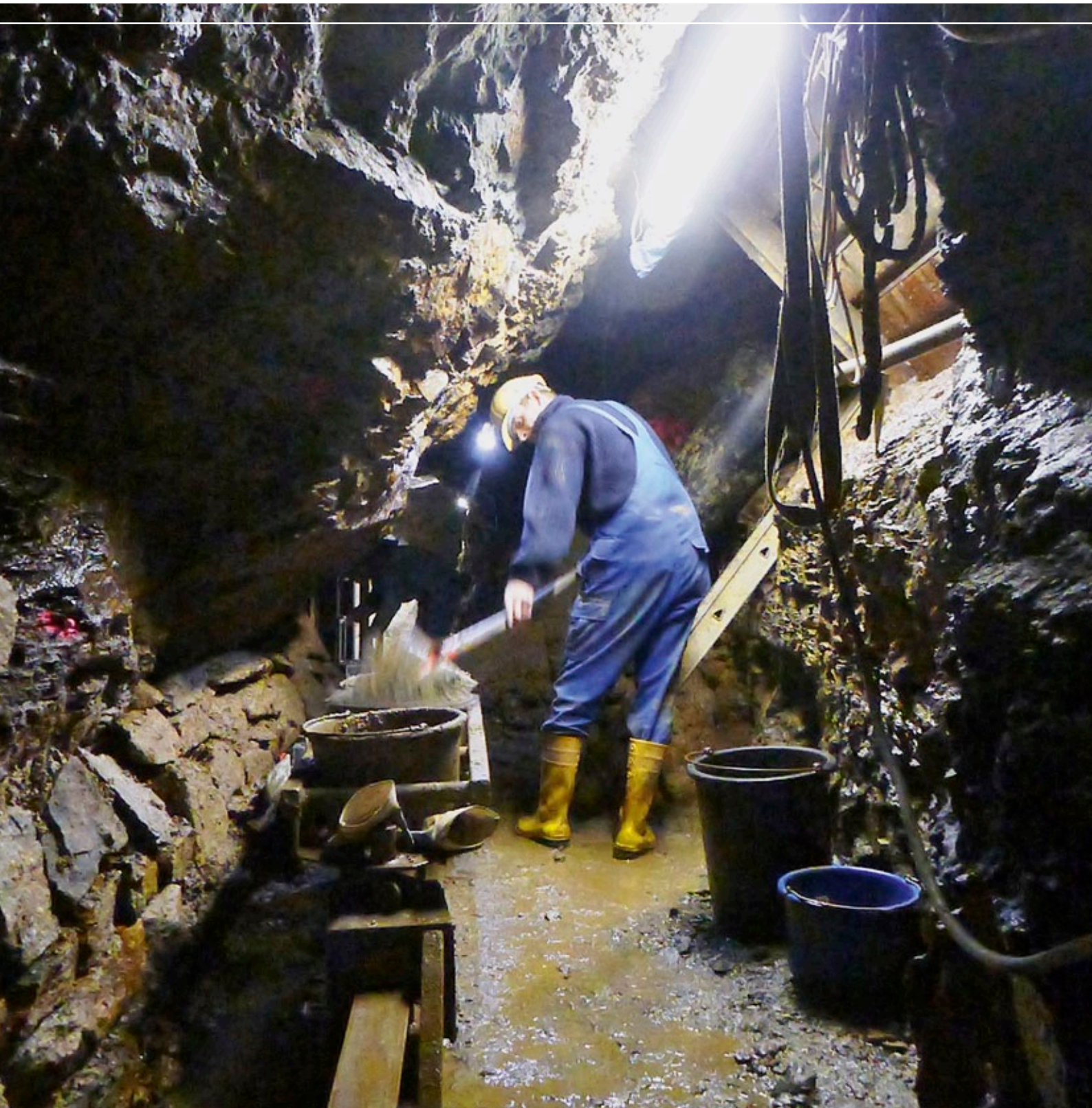
Sicherungsarbeiten an der Baustelle Karlsbader Straße in Annaberg-Buchholz
