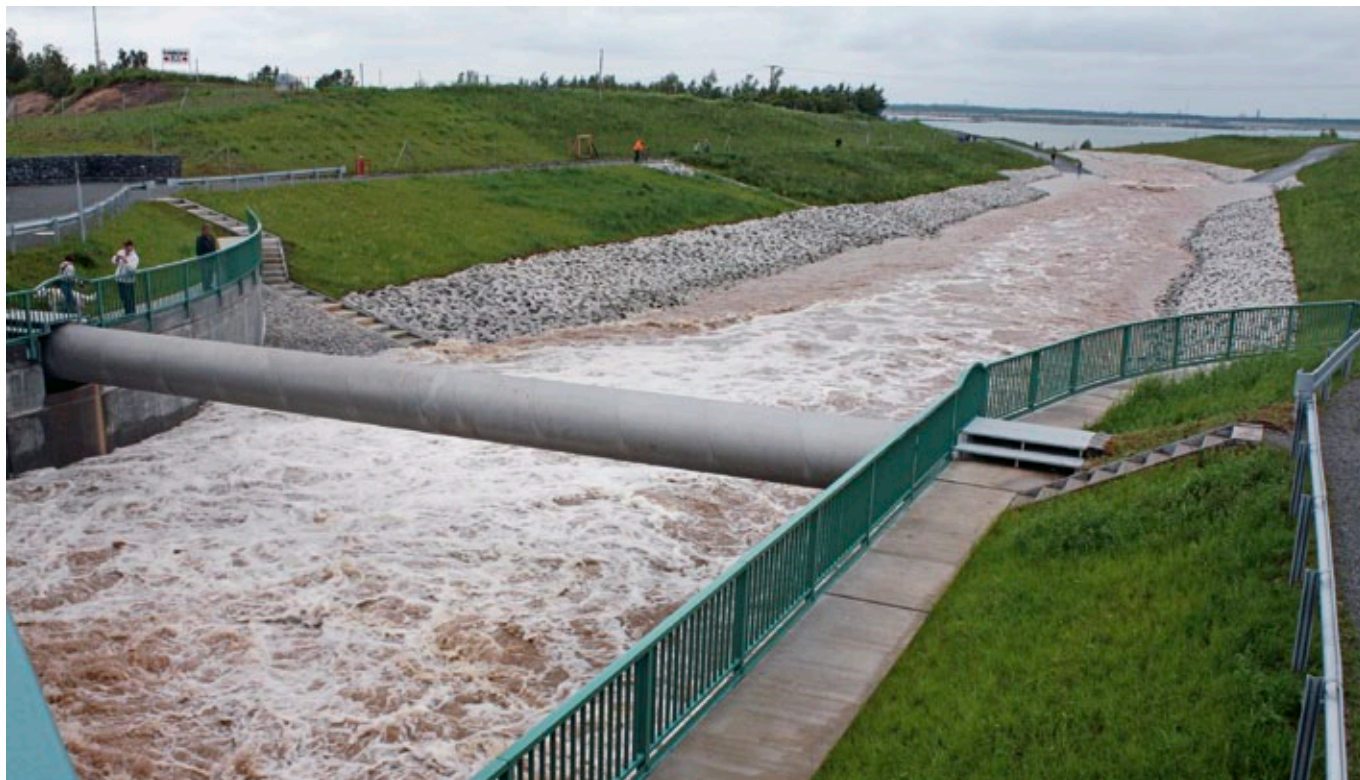
Das geöffnete Einlaufbauwerk Zitzschen beim Junihochwasser 2013
