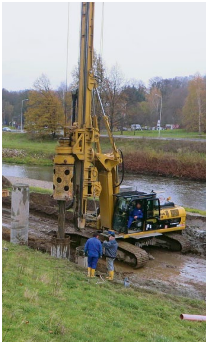
Abdichtung Stahlspundwand in Zwickau-Schedewitz – Einbringen von Bohrpfählen
