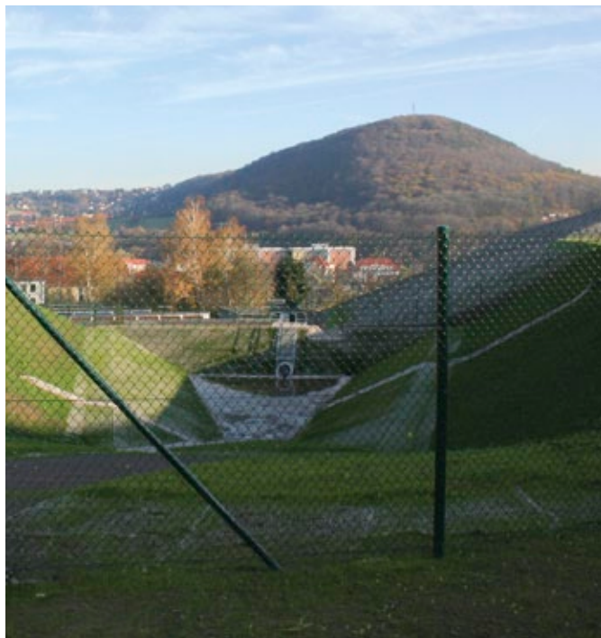
Bereich der sanierten Kettenberghalde in Freital mit Regenrückhaltebecken
