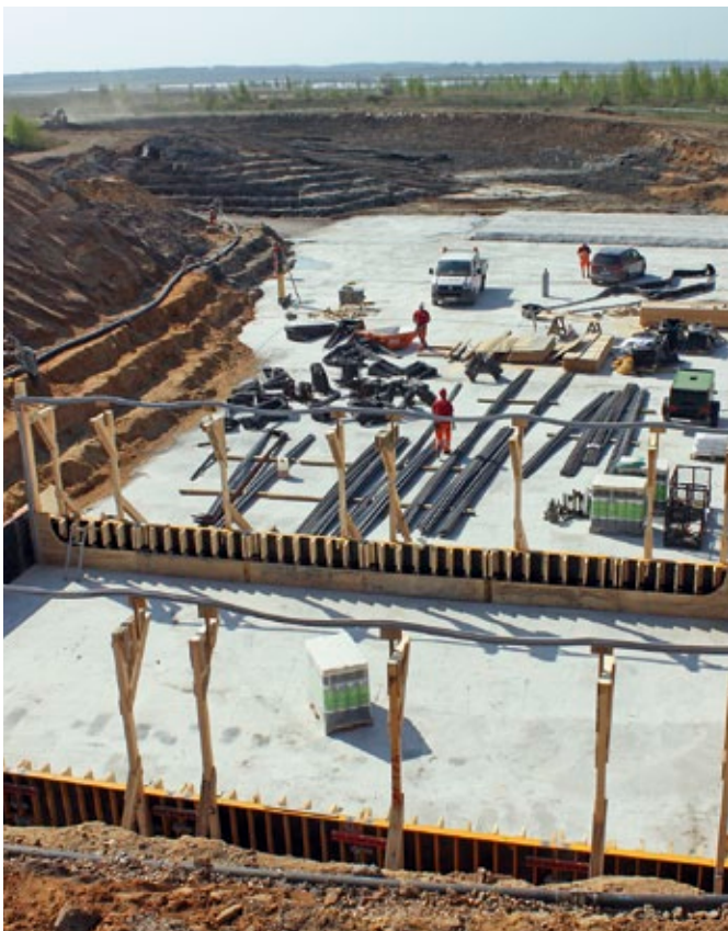
Bau Auslaufbauwerk vom Zwenkauer See in die Weiße Elster
