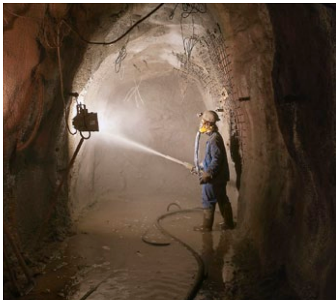
Auffahrung des Südumbruches auf der Markus-Semmler-Sohle in Bad Schlema – Ausbau
