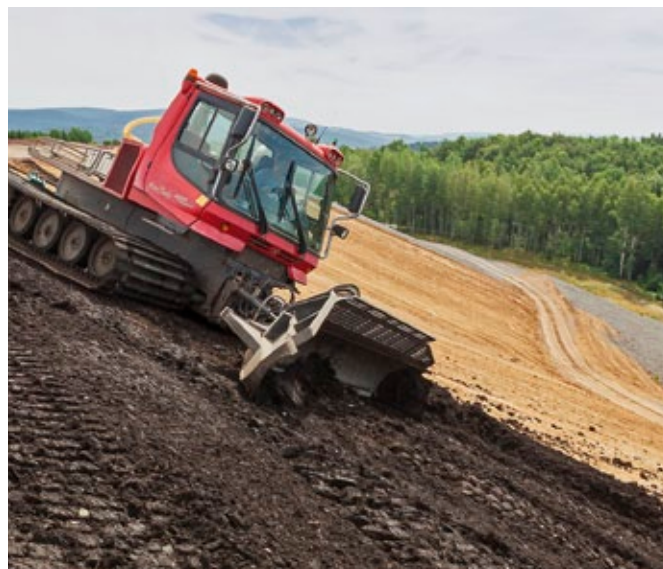
Halde 309 in Bad Schlema – Aufbringen von Humus auf die mineralische Dämmschicht
