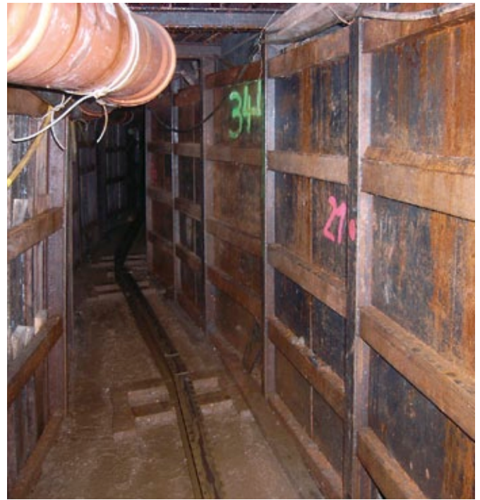
Verwahrung Aaron Stolln in Johanngeorgenstadt – Abschnitt mit vollständigem Stahlausbau
