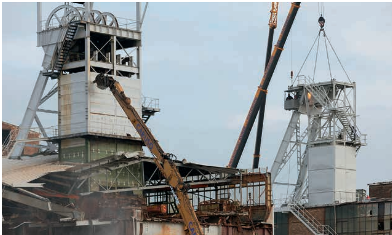
Rückbau des Schachtkomplexes 388/390 am Standort Königstein
