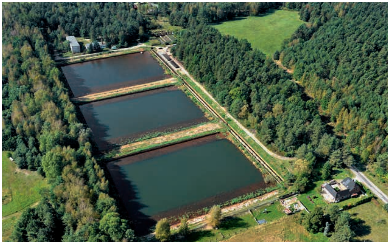
Grubenwasserreinigungsanlage in Burgneudorf
