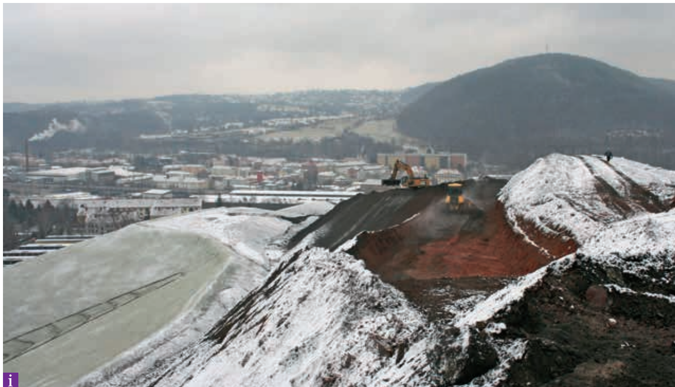
Paul-Berndt-Halde während der Sanierung; Bild von sanierter Halde, siehe S. 30
