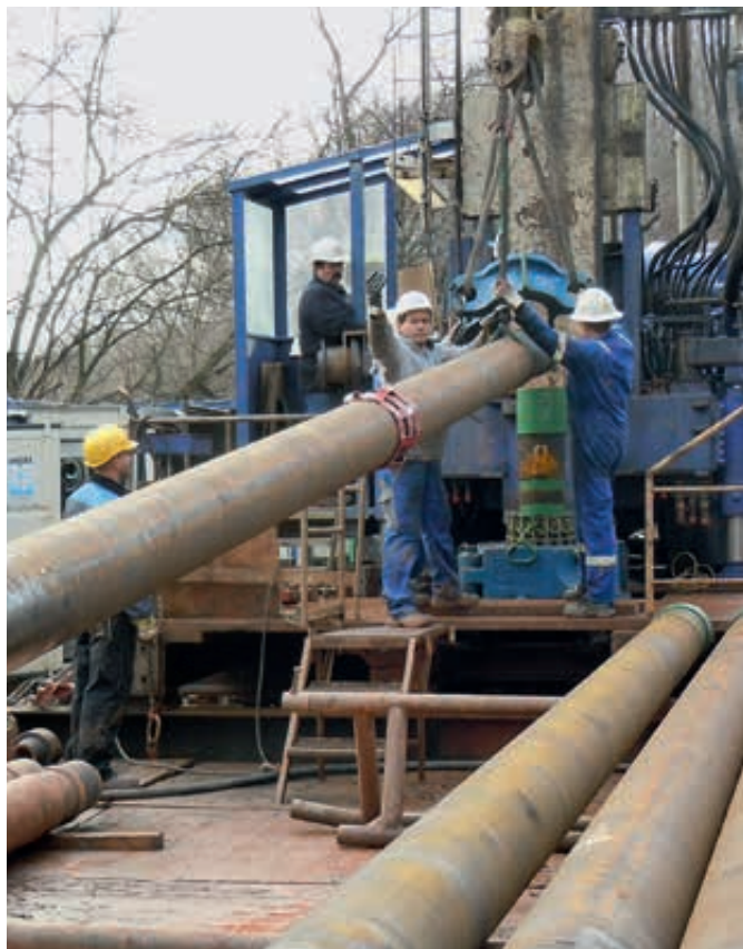
Rohreinbau während der Bohrung zur tiefen Grundwassermessstelle Gersdorf.
