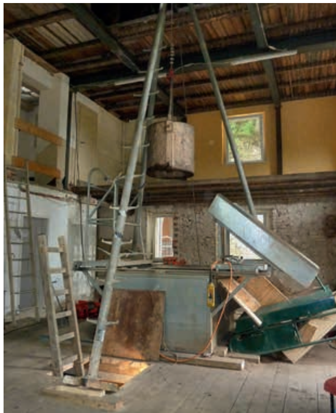
Aufwältigung des Hoffnungsschachtes über dem König-David-Hilfsstolln in Scharfenberg in einem zwischenzeitlich entkernten Wohnhaus
