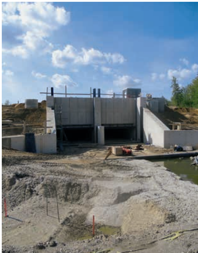
Bau Auslaufbauwerk (Rahmendurchlass) vom Zwenkauer See in die Weiße Elster
