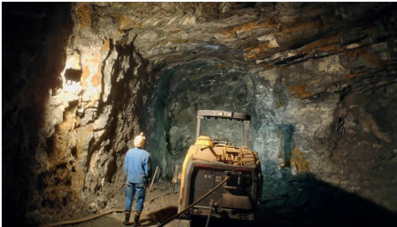
Flussspatgrube Niederschlag – Vortrieb
