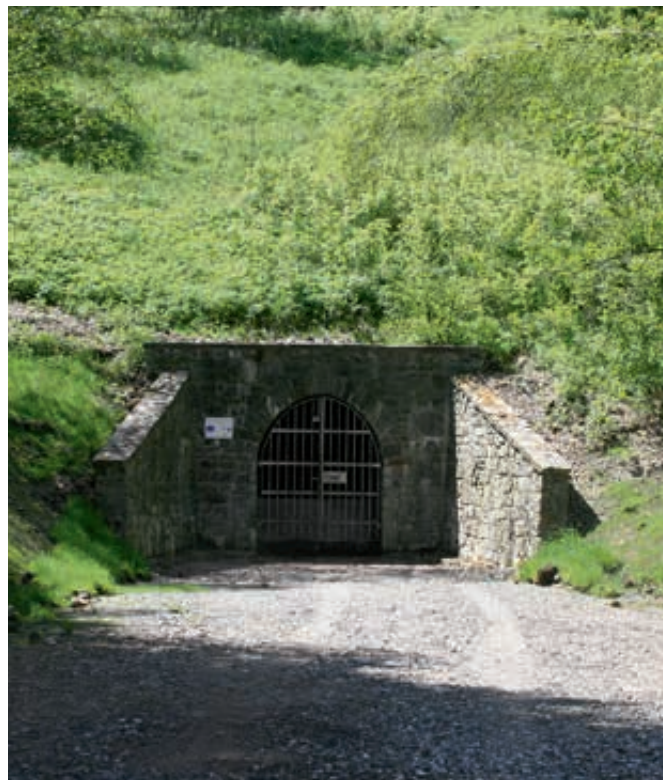
Aaron Stolln in Johanngeorgenstadt – Mundlochbereich nach Abschluss der Sanierung
