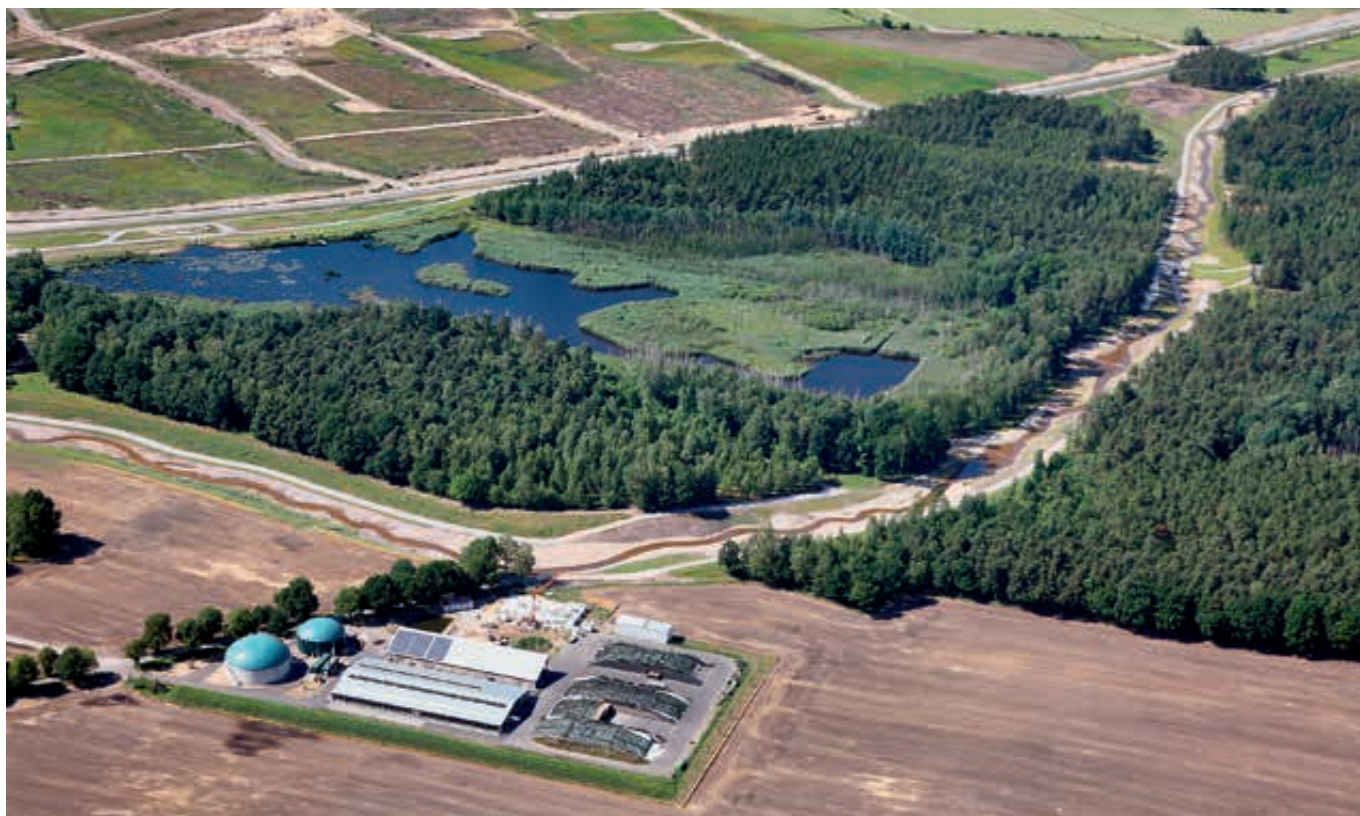
Umverlegung des Weißen Schöps im Vorfeld des Tagebaus Reichwalde
