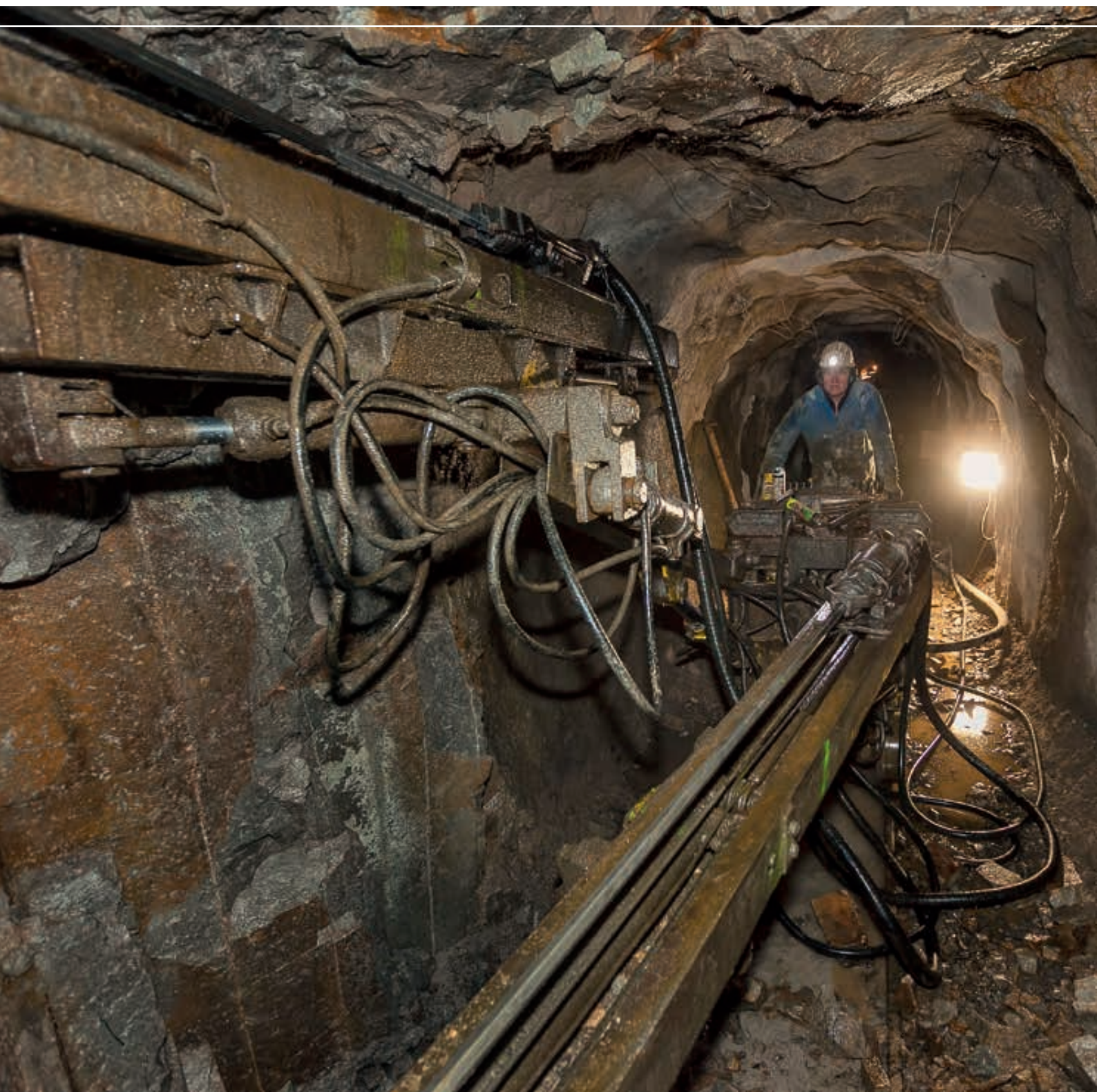
Auffahrung des Südumbruches auf der Markus-Semmler-Sohle in Bad Schlema – Bohren der letzten Löcher für den Durchschlag
