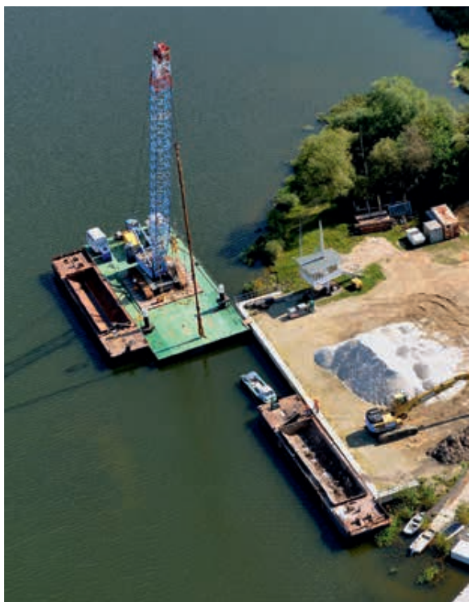
Sanierung Knappensee – Einsatzstelle für die seeseitige Rütteldruckverdichtung
