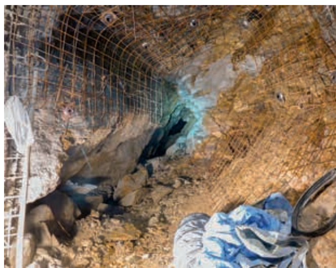
Grubenbauverwahrung Tagesbruch Dörfler Weg in Annaberg-Buchholz – Einbau der Bewehrung in ehemaligen Abbaubereichen
