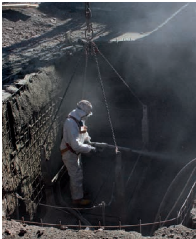
Sicherung Schachtkopf Albert-Funk-Schacht 1 vor der Verwahrung
