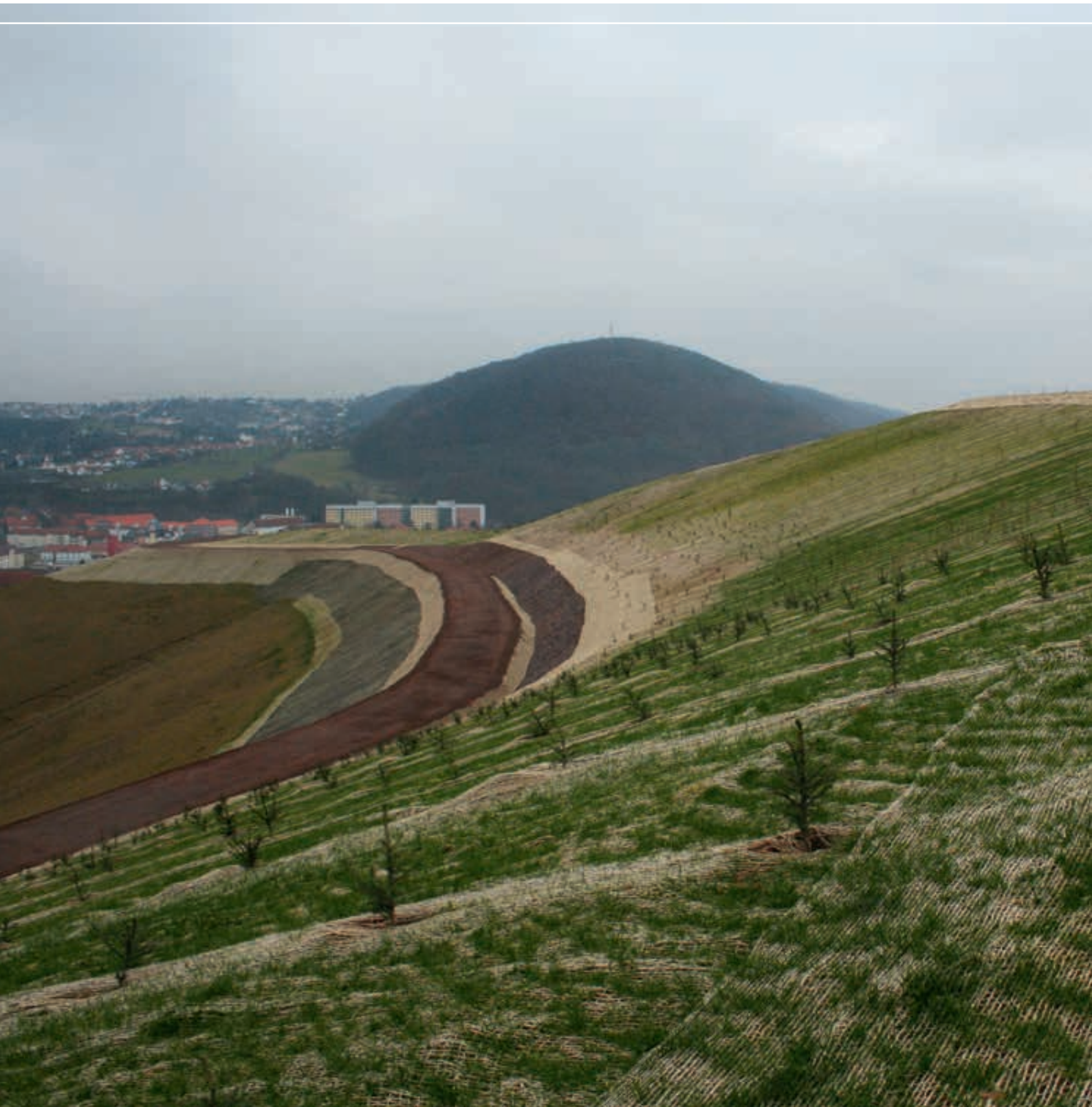
Paul-Berndt-Halde in Freital nach Abschluss der Sanierungsarbeiten
