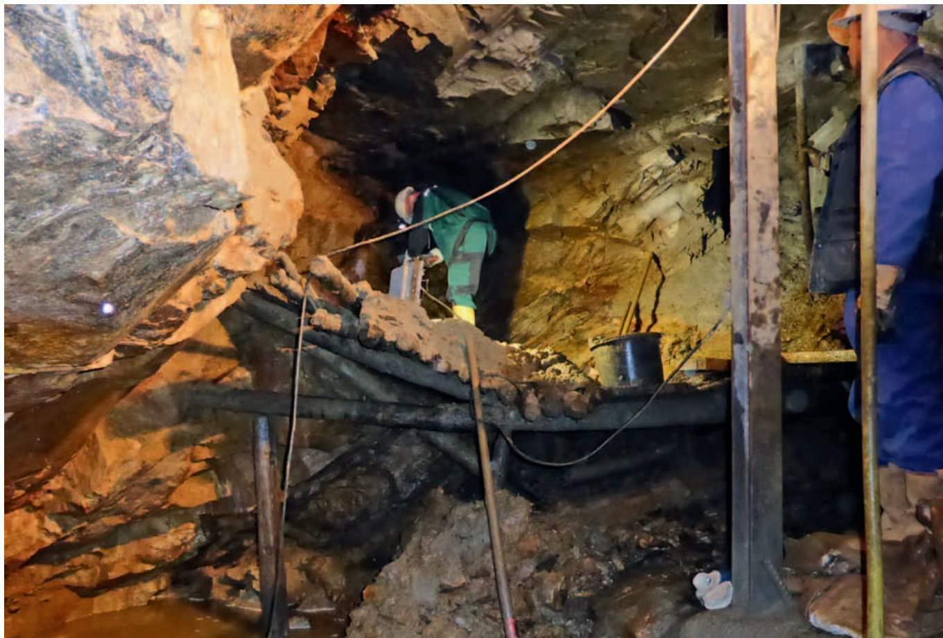
Aufwältigung und Sicherung der Hohlräume in Annaberg-Buchholz im Bereich Schlachthofstraße/Badeweg
