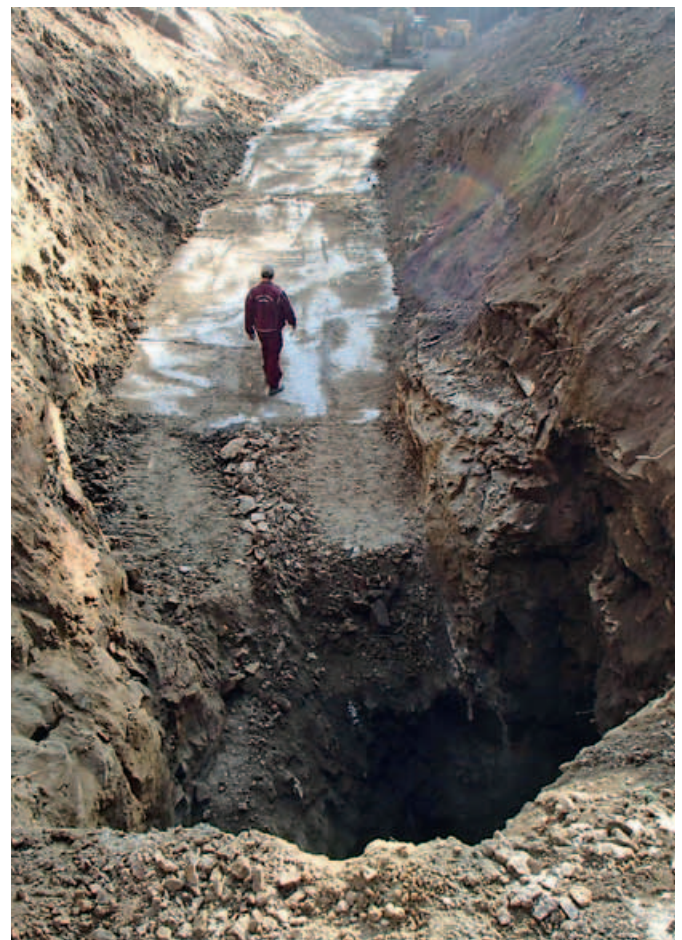
Verwahrungsarbeiten im Bereich der tagesnahen Gänge 57 und 57a
