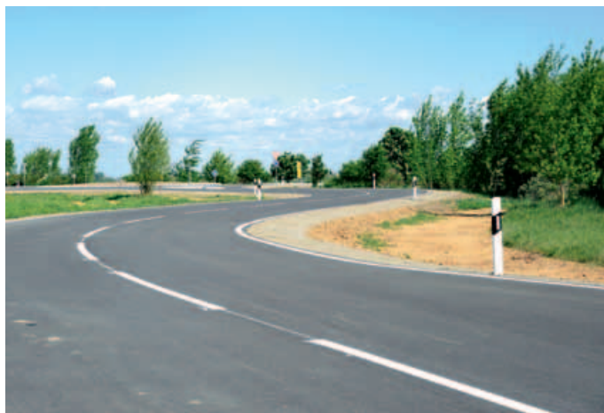
oben: seeseitige Holzungsarbeiten im Zwenkauer See unten: nördlicher Straßenanschluss für den Werbeliner See
