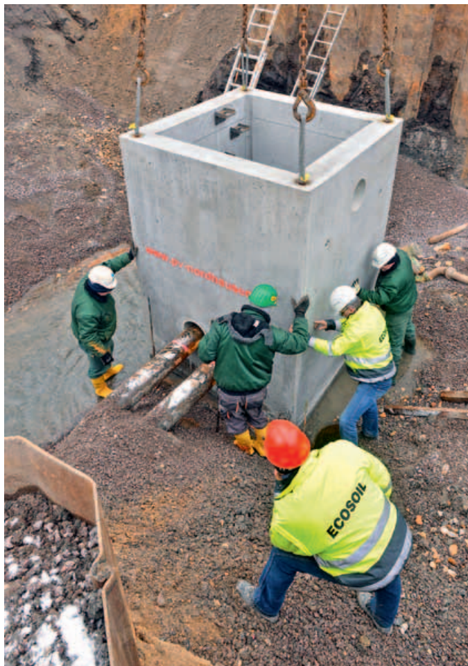
Loberausbau in Delitzsch – Bau eines Spülschachtes
