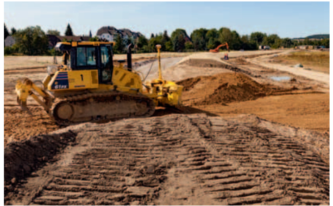
Bau Hochwasserschutzdeich im Bereich der Industriellen Absetzanlage Crossen
