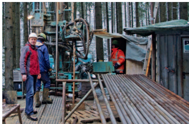
Erkundungsbohrung im Erlaubnisfeld »Ehrenfriedersdorf-Geyer I«
