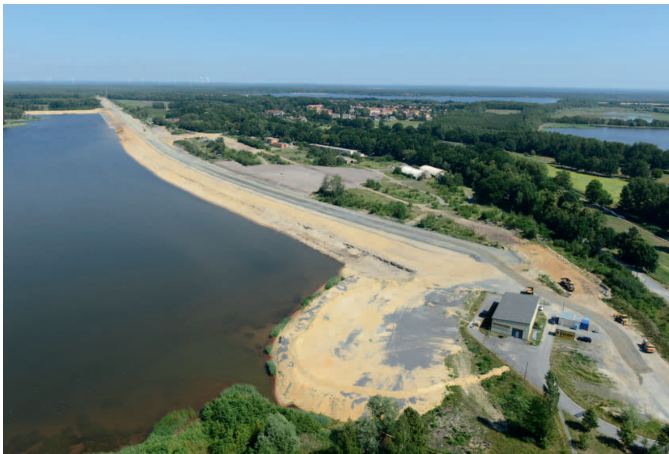
Sanierte Ostuferböschung am Silbersee
