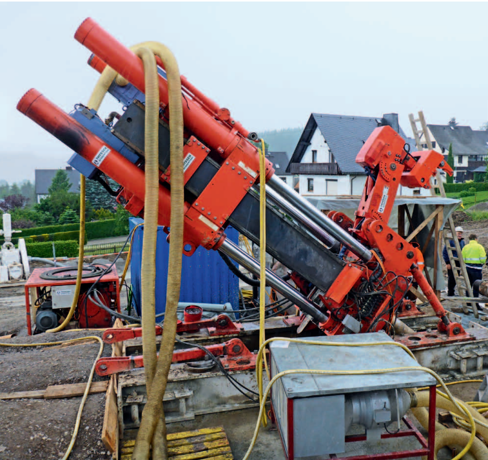
Schrägbohrung zur Herstellung der Wasserabtragsfähigkeit im Grubengebäude Breitenbrunn
