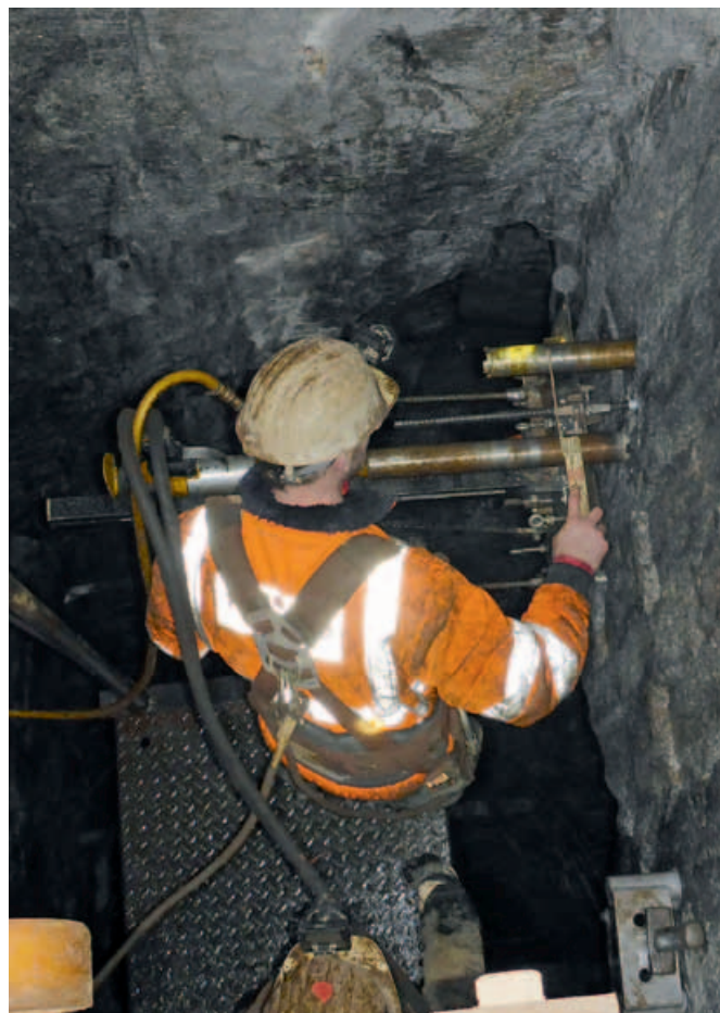
Sicherung und Ausbau des Dreibrüderschachtes in Freiberg – Bohren von Kappschuhlöchern
