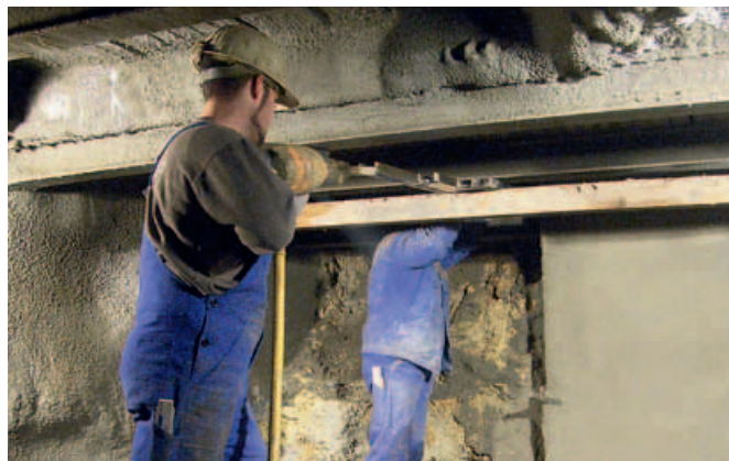
Aufwältigungsarbeiten im Hauptstollengang Stehender unter der Feldstraße in Freiberg
