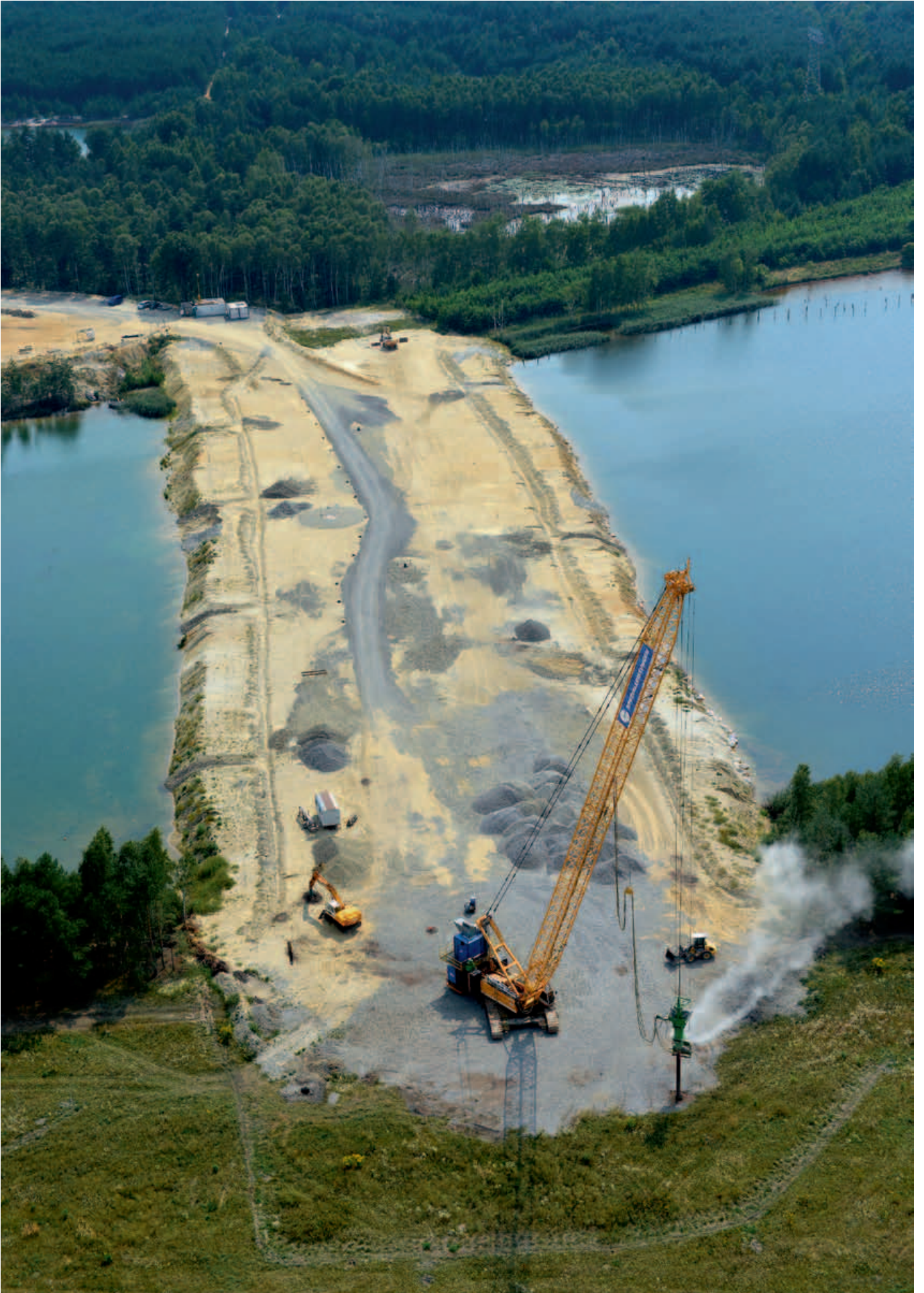
Errichteter standsicherer Damm im Restlochkomplex Heide
