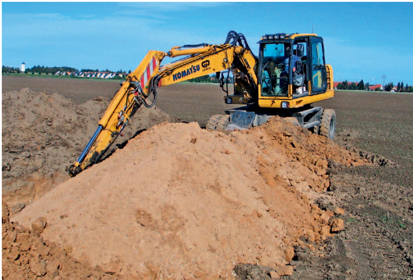
Amtliche Probenahme durch Baggereschurf für die Tagebauerweiterung einer Kiesgewinnung
