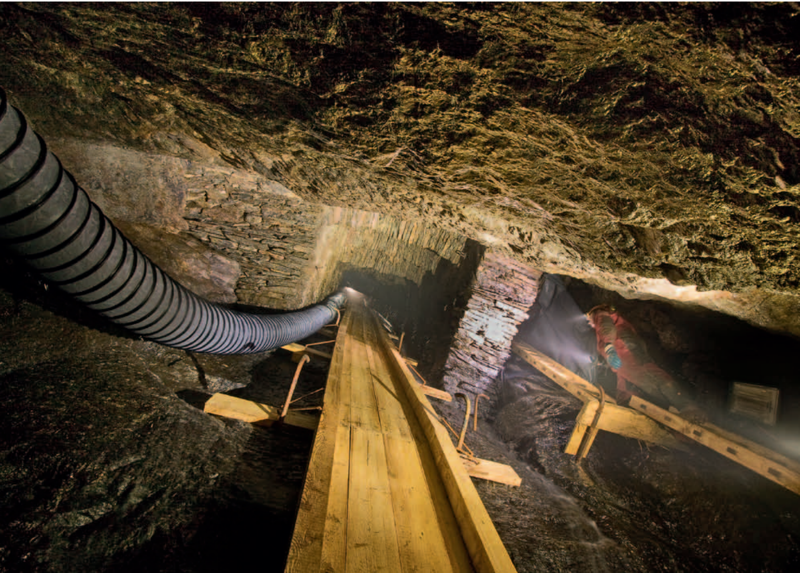
Kaiser-Heinrich-Schacht bei Marienberg (Erzgebirgskreis) während der Arbeiten zur Gefahrenabwehr aus dem Altbergbau
