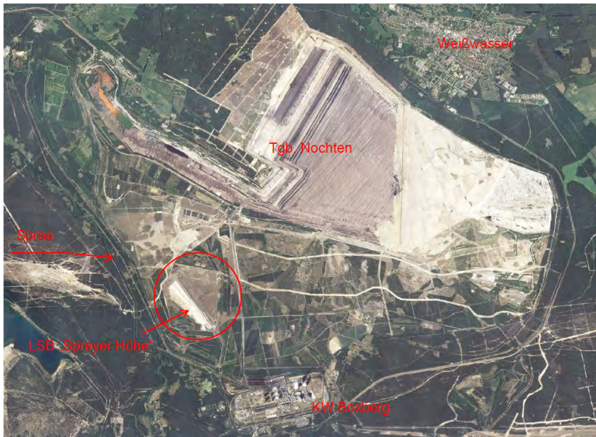
Abbildung 8-20: Landschaftsbauwerk Spreyer Höhe [LE-B]
